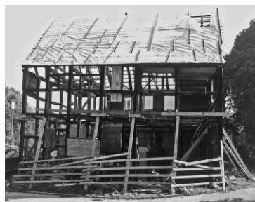
bei der Renovierung
