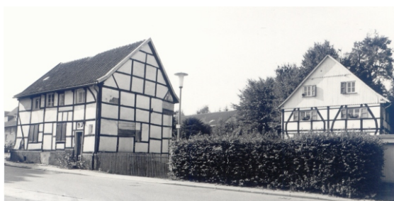
vor der Renovierung
