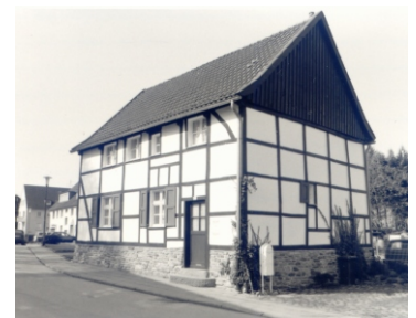
nach der Renovierung
